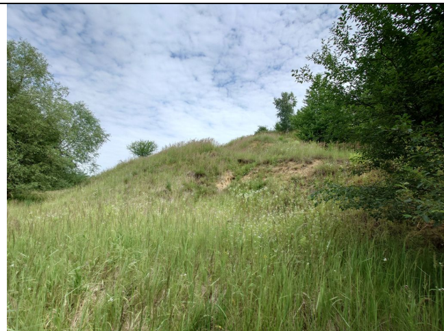
Wysokie czoło osuwiska na dnie wyrobiska.
